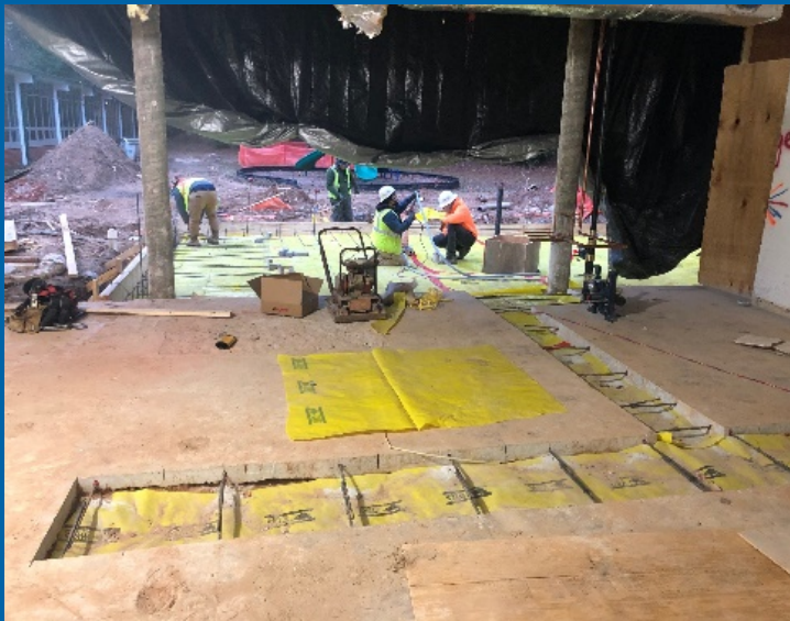
Interior Slab Pour Backs Prepped for Concrete
